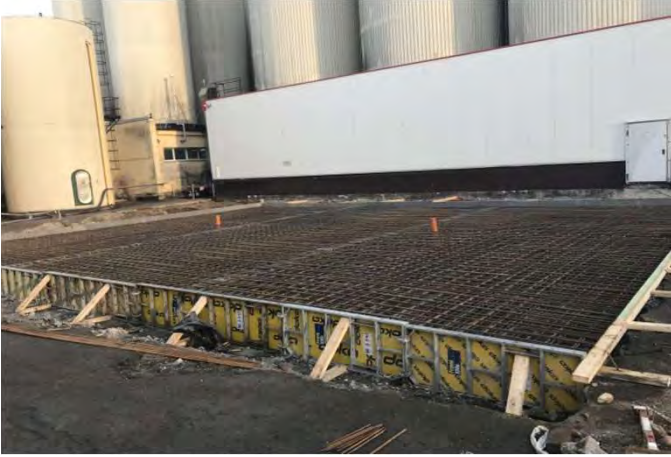
Heineken Sörgyár tartályok alatti rész alapozása
